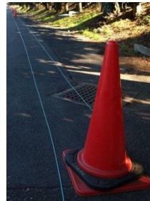
図1.ケーブル延線試験の様子
