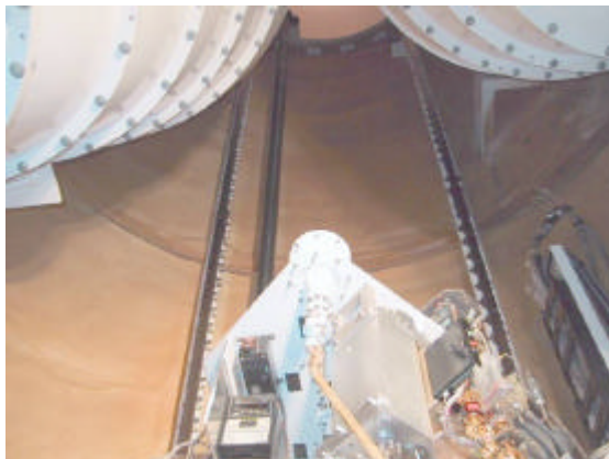
図 2 22GHz 帯 / 43GHz 帯受信機のトロリー 左右の 2 本のレールに沿ってトロリーが昇降して、受信機を焦点位置へ移動させられる構造になっている。
