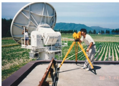
写真-14 EL 軸の高さを決めるため、新十津川人工衛星観測室の屋上で水準測量を行なう唐沢正夫。1990年7月
