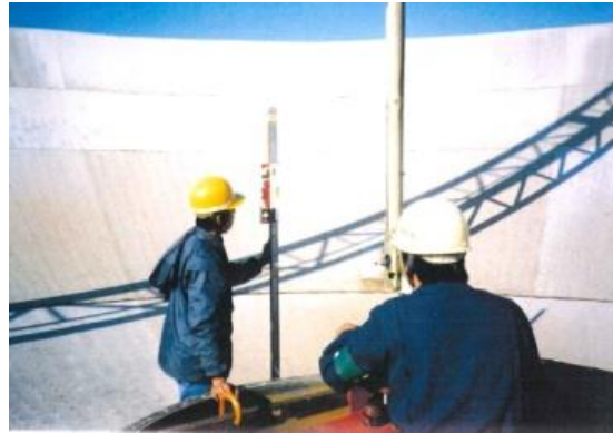
写真-19 トータルステーションを用いて、ボルト交換前後の鏡面パネルの高さの差を0.5mm以内に調整した。この作業は、ボルト1本ごとに行なった
