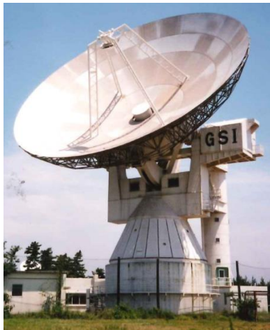
写真-21 大規模改修後の26mアンテナ。地理院に移管されたので、「GSI」の文字をアンテナ受信機室の外壁に記入した
