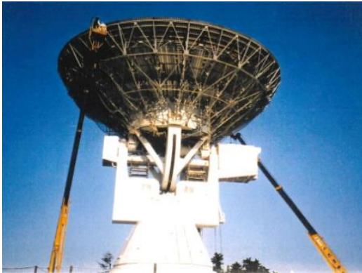
写真-18 ボルト交換は、クレーンを使うなどした高所での作業が長期間にわたった。バックアップストラクチャには工事用踏み板を敷き詰めた
