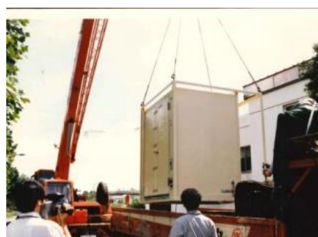
写真-15 水素メーザは、クレーンで吊り下げられている箱(恒温槽)の中に入っている。普段は右側の建物内に設置してあるので、上空から吊り上げ、搬出する
