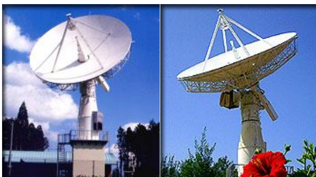
写真-27 1997年に新たに整備されたVLBI固定観測局。左は始良局(鹿児島県)、右は父島局(東京都)。両アンテナとも直径10mで米国Scientific-Atlanta社製アンテナを使用し、日本通信機が納入
