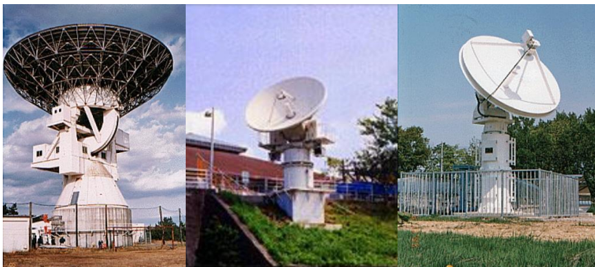
写真-26 左から、鹿島26m局、海南5m移動局、新十津川3.8m固定局。測地成果2000では、これら3局のVLBI局の座標が使われた。
