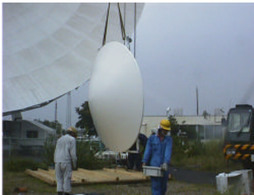
写真1：吊り上げ中の副反射鏡
