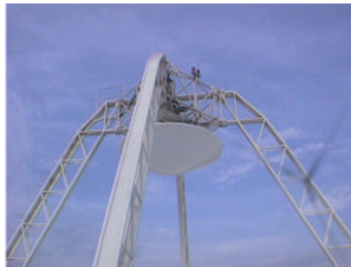
写真2：取り付けられた副反射鏡
