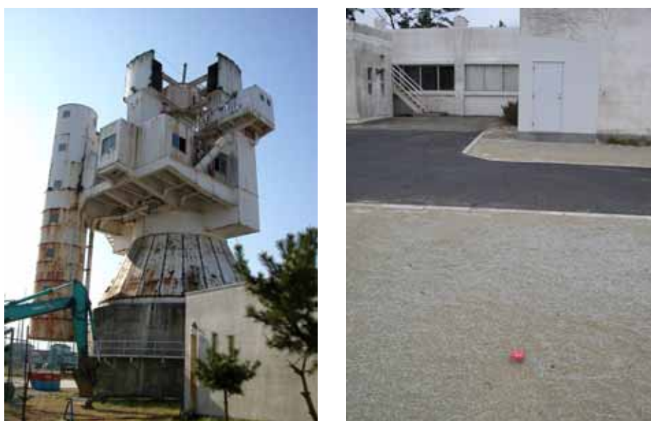
図6 解体途中(左:2003年1月13日)と解体後(右:2003年4月11日)。右の写真手前に写っている杭がアンテナのAZ回転軸だった場所。
