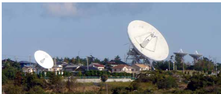
図4. 鹿島 34 m アンテナ（右）と鹿島（KSP）11 m アンテナ（左）
