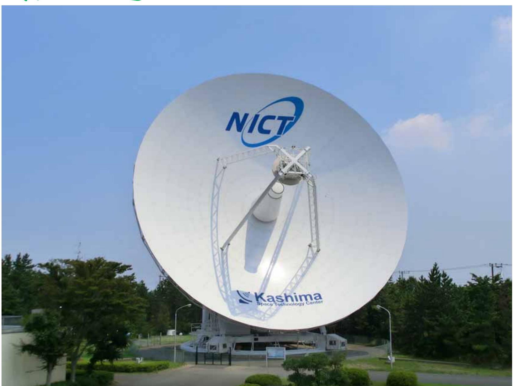
図1 主鏡面を再塗装した 鹿島34mアンテナ
