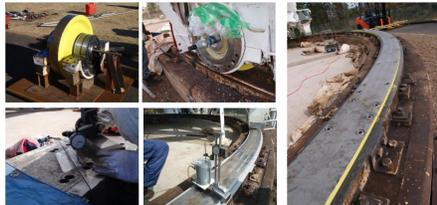
図4 新品の車輪(左上)、車輪設置はAZ円周軸の芯出しを行ない、その中心軸に対して望遠鏡を使って1.e-5radの精度で設置(上中)、AZレールのベースプレート接合部は0.1mm以下の精度を要求して測定・研磨し、場所によってはシムによる調整を行なった(下左)。レール全周にわたって平面からの残差RMS0.1mmとなるように測定と研磨を繰り返した(下中)。新品のウェアストリップを設置したレール(右)。
