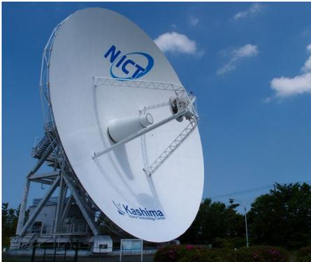
鹿島34mアンテナは、マイクロ波帯の受信機を複数搭載した国内で3番目に大きな高感度の電波望遠鏡施設です。主目的の周波数比較VLBI観測の他に、パルサー、木星、アンモニア分子雲の電波天文観測や、準天頂衛星のL帯信号特性の確認観測など、単鏡観測として共同研究に基づく観測にも活用しています。
