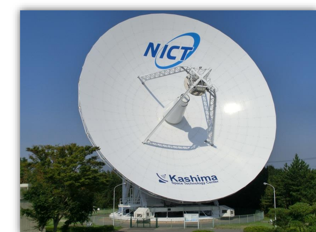
図7 産総研(つくば)に設置した小型アンテナ(上左)と、NICT2号館屋上の小型アンテナ(上右)、および小型アンテナの感度をブーストする役割を果たす鹿島34mアンテナ(下)。
