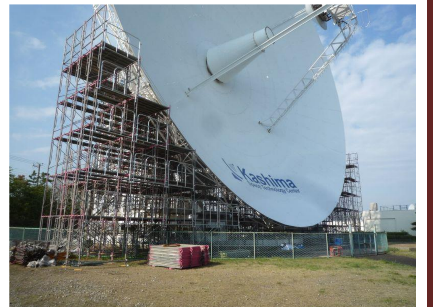
図10. 鹿島34m背面構造部の補修塗装(4月～5月) アンテナ傾斜時に地上に近づく箇所に足場を仮設、下側の三分の一程度の補修塗装を実施した。毎日の作業終了後には強風に備えてアンテナを天頂へ戻した。
