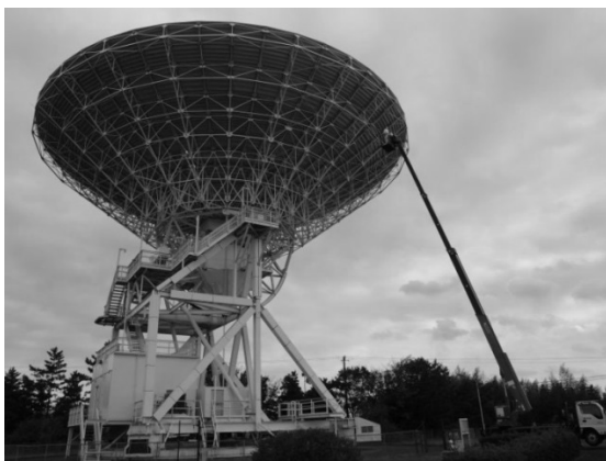
図 11. 前回 2015 年の補修範囲外の背面構造部腐食の進行が懸念され、高所作業車による調査を 2017 年 10 月に実施、補修工事設計を行っており、2018 年 3 月から数ヶ月間の補修工事を予定している。
