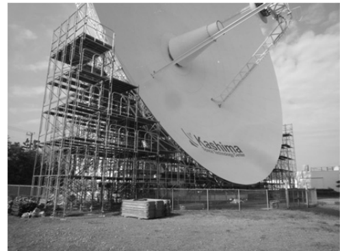
図 10: 鹿島 34m 背面構造部の補修塗装(2015 年 4 月～5 月) アンテナ傾斜時に地上に近づく箇所に足場を仮設、下側の三分の一程度の補修塗装を実施した。
