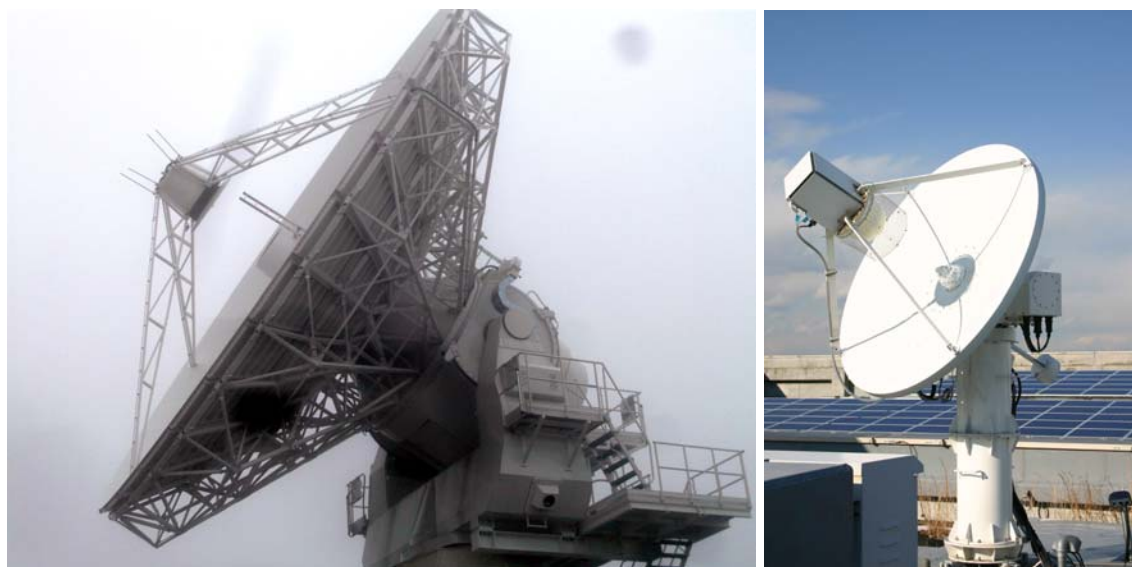
図 1: VLBI2010 仕様として建設されたドイツ Wettzell の Twin-Telescope の 2 つのアンテナのうちの 1 つ (左) と、NICT が VLBI2010 仕様を開発している MARBLE 小型 VLBI アンテナ (右)
