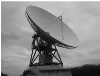
図 1. 避雷針が取付けられた高萩アンテナ
