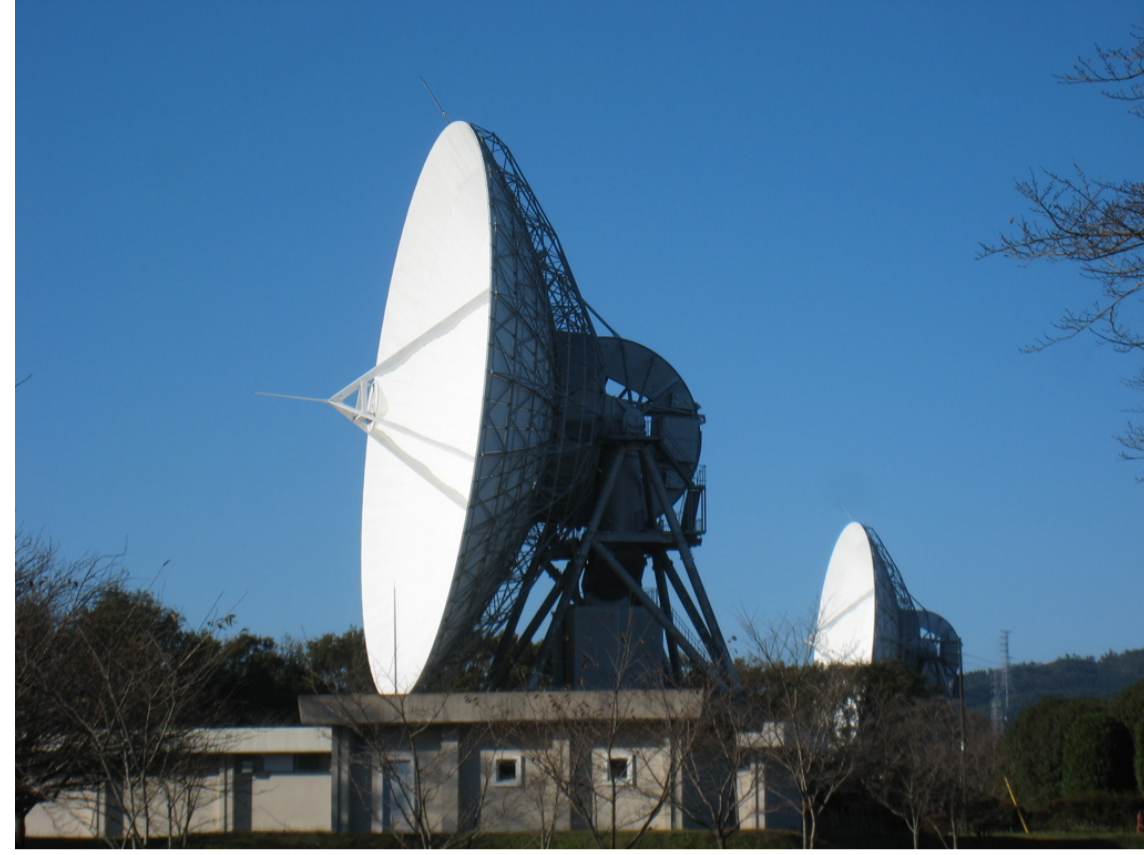
図1 茨城局。 図中手前は高萩32mアンテナ, 奥は日立32mアンテナ。
