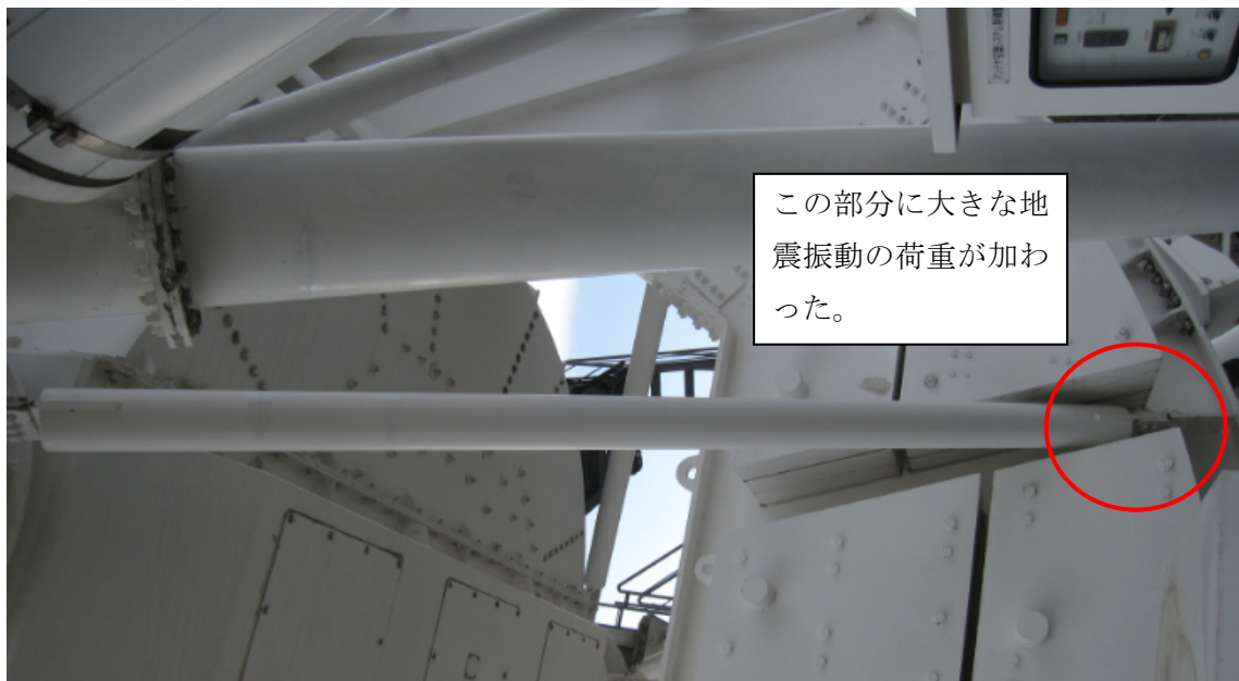
写真4 カウンターウエートをエレベーション回転軸で支える斜材 セクターギヤが左右に振れることを制限するために、セクターギヤのカウンターウエート部と仰角回転軸受けを連結している斜材
