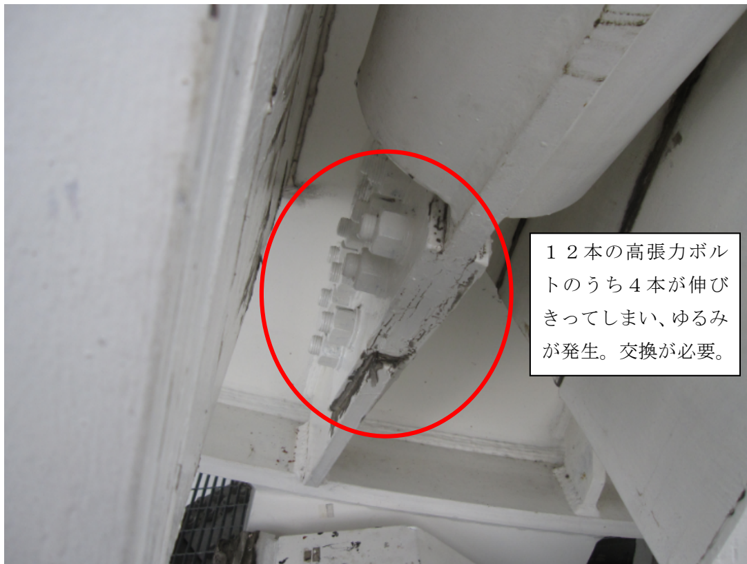
写真5 斜材をカウンターウエートに結合しているガセットとボルト
