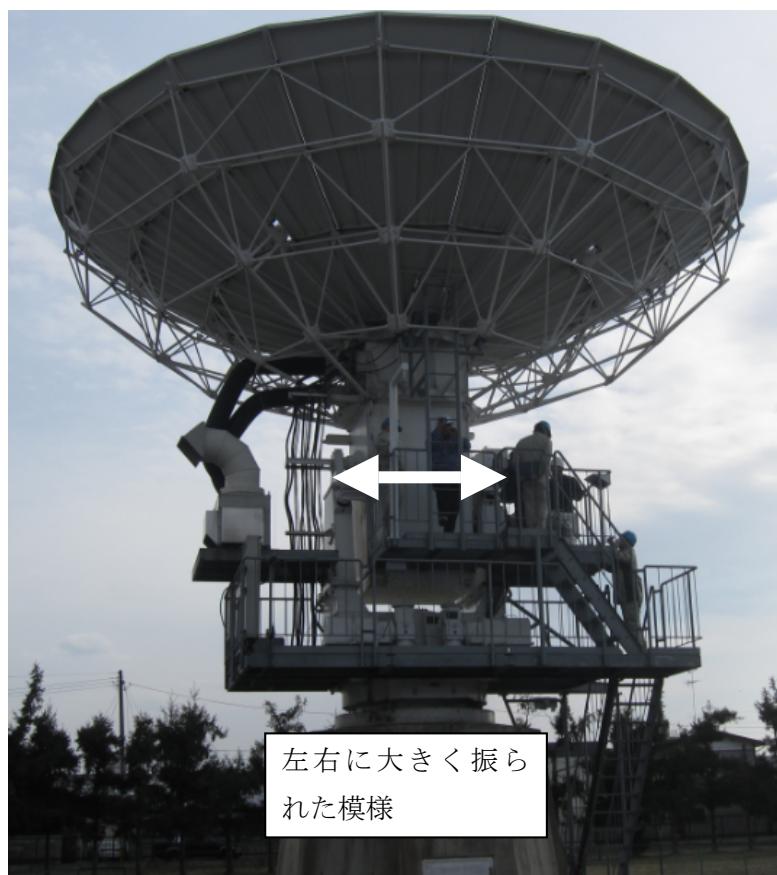
写真7 水沢V L B I 10m アンテナ全景
