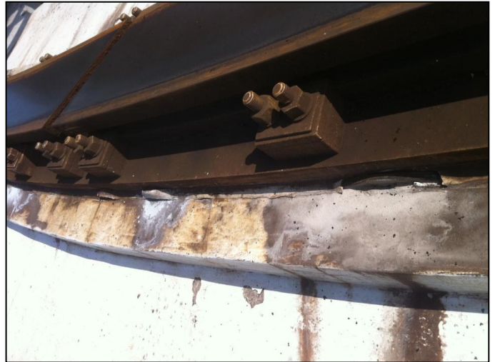
(写真1)水に溶けたグラウトが、ソールプレートの横から吹き出している。レールの隙間は点検ごとに位置が変わっており、レールが動いている。
