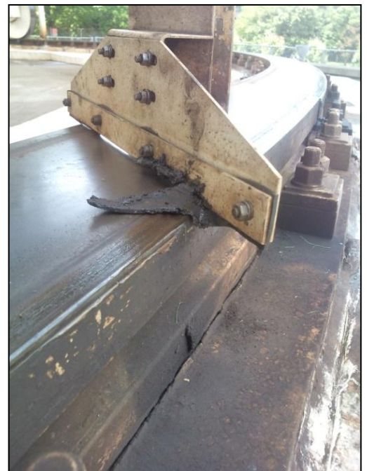
(写真2)レールスライパーのゴムが、レールと干渉してめくれている。なお、ゴムは一ヶ月前の保守点検時に交換したばかりである。
