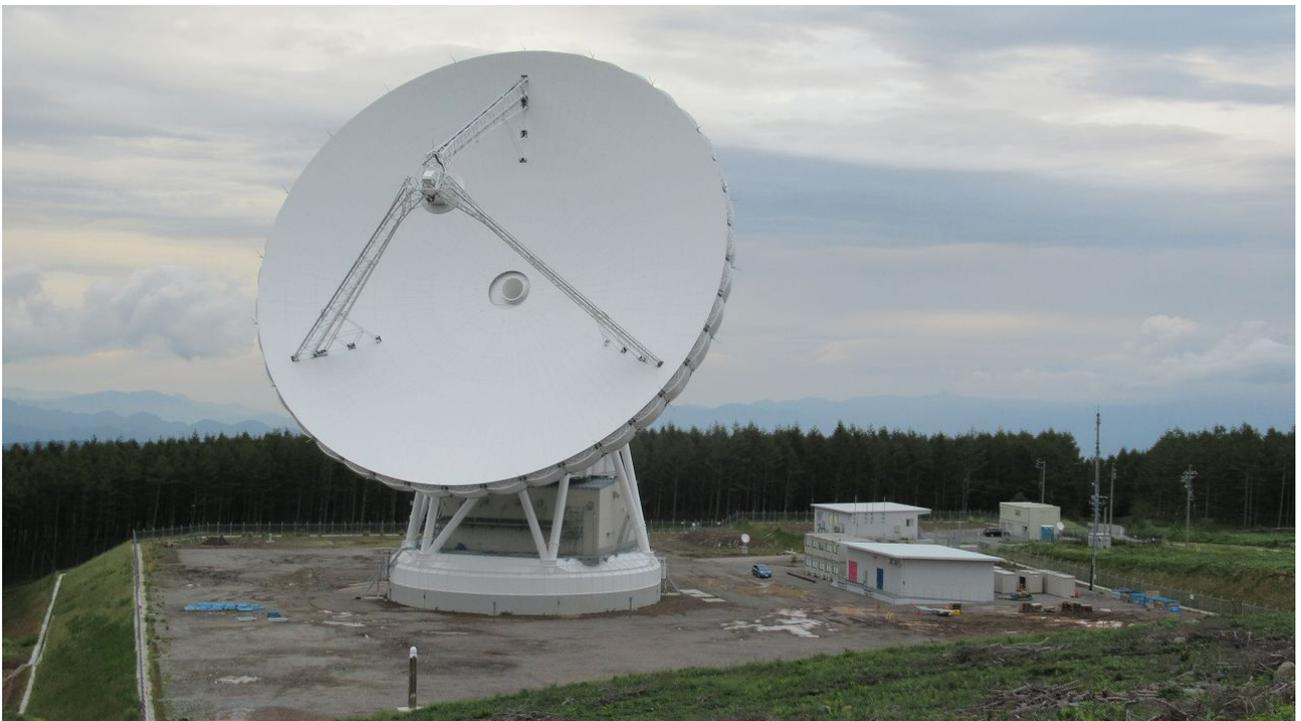
2020 年度完成を目指して建設中。送信機がクライストロン型増幅器から半導体増幅器に変更となりそのためのスケジュール変更はあったが、そのほかはほぼ予定通りに建設継続中 (今年中にはやぶさ 2 からの電波受信予定)。アンテナサブシステムはほぼできており、試験に入っている。8 月に通信機器、9 月に冷却増幅器、VLBI バックエンドが入る予定。インテグレーション試験が開始している。建設の現状は <http://www.isas.jaxa.jp/home/great/> で確認できる。写真は、2019/8/23 撮影
