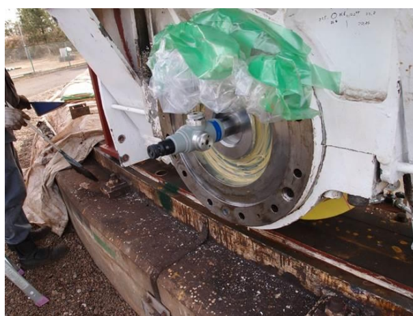
写真2 交換された車輪は望遠鏡を使って設置調整を行った。
