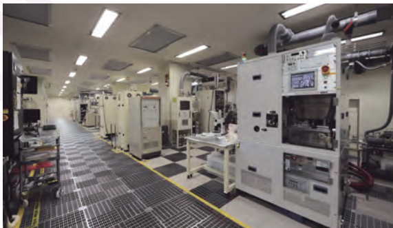
クリーンルーム内のプロセス装置
