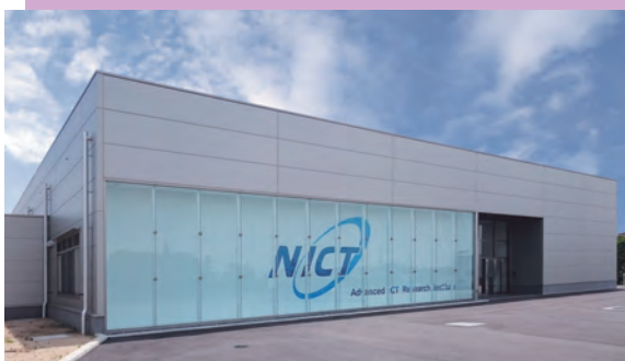
神戸クリーンルーム外観写真
