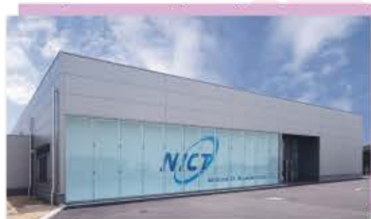
神戸クリーンルーム外観写真
