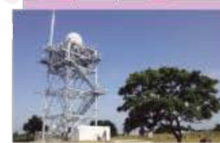
未来ICT研究所に設置されたPANDA鉄塔とコンテナ
