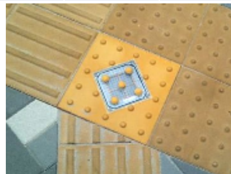
日本初の「ICタグ付き点字ブロック」を埋設
