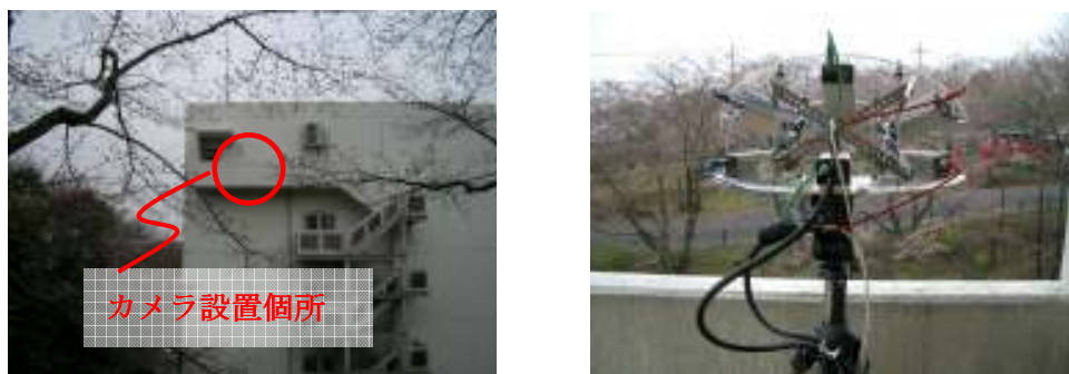
図 12 カメラ設置個所と設置状況
