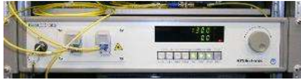
図5-1-4-5 光アンプ外観
