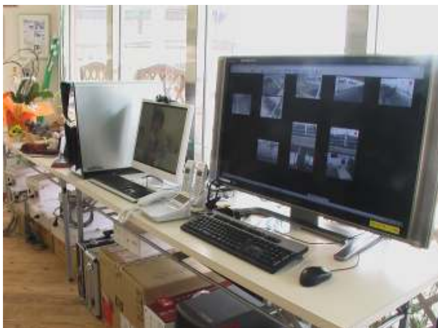
図 4-3-2-1 構築した多地点モニタリングシステム
