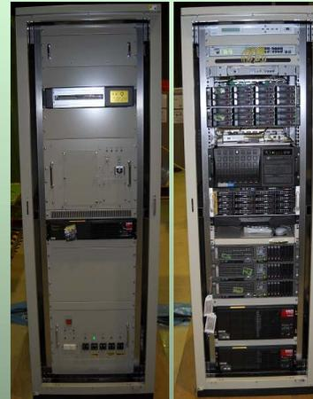
レーダ制御装置 レーダ処理装置
