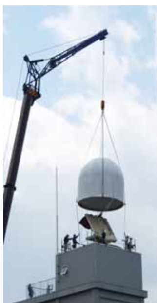
クレーンで吊り上げ 設置中のレドーム
