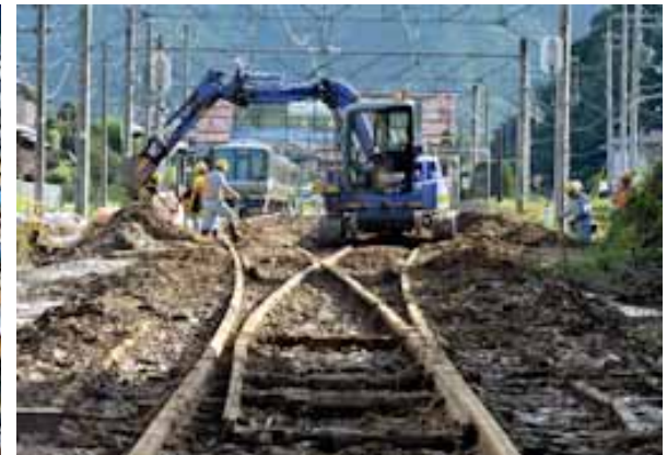
JR福知山線復旧作業(18日)
