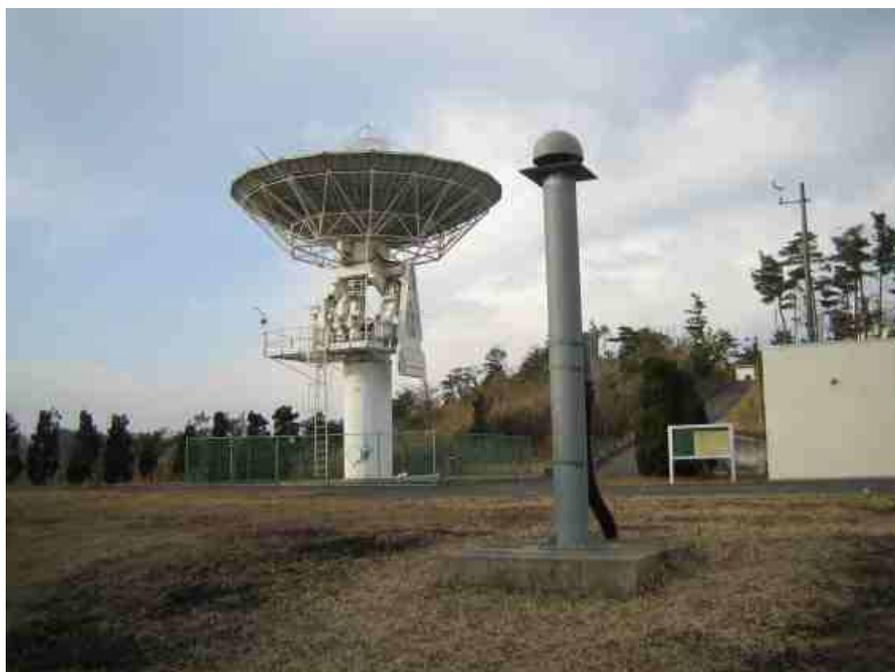
図 2.25: NICT で運用する GPS 観測点 (鹿島 KSMV 局)。後方は 11m アンテナ。
