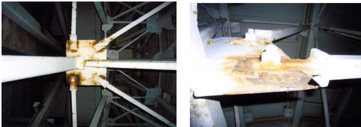
図 4.2: バックストラクチャーの重度な発錆。
