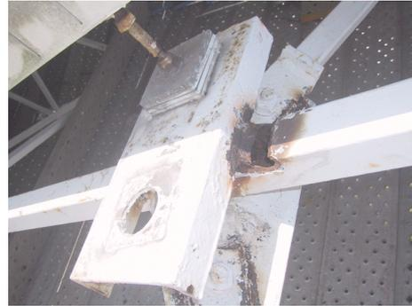
図 4.5: 主鏡パネルをはずして上側から見た典型的な腐食部分の例
