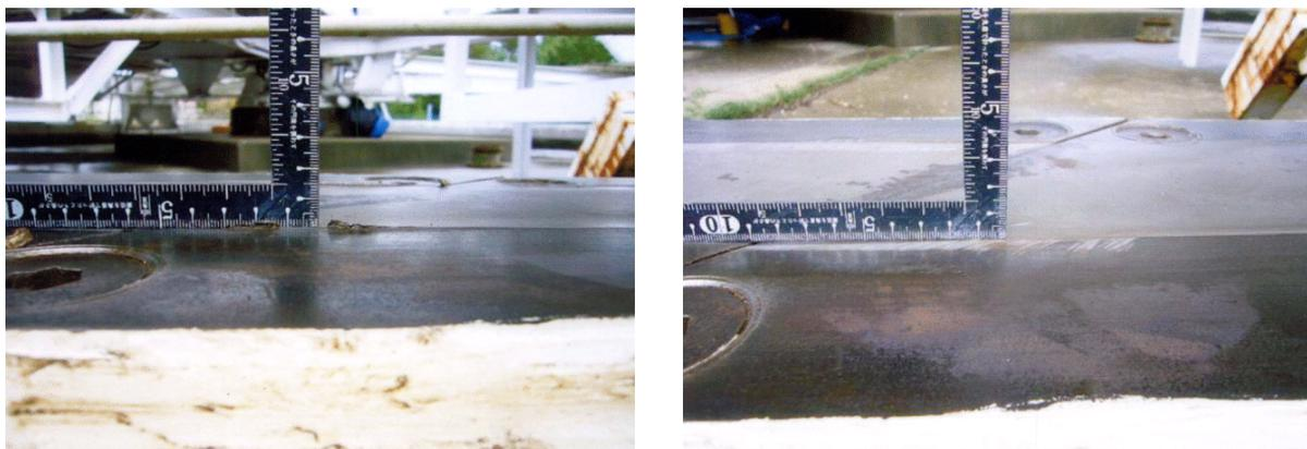
図 4.1: AZ レールのバリ(左図)とディスクグラインダーを用いてバリを除去した後の様子(右図)。
