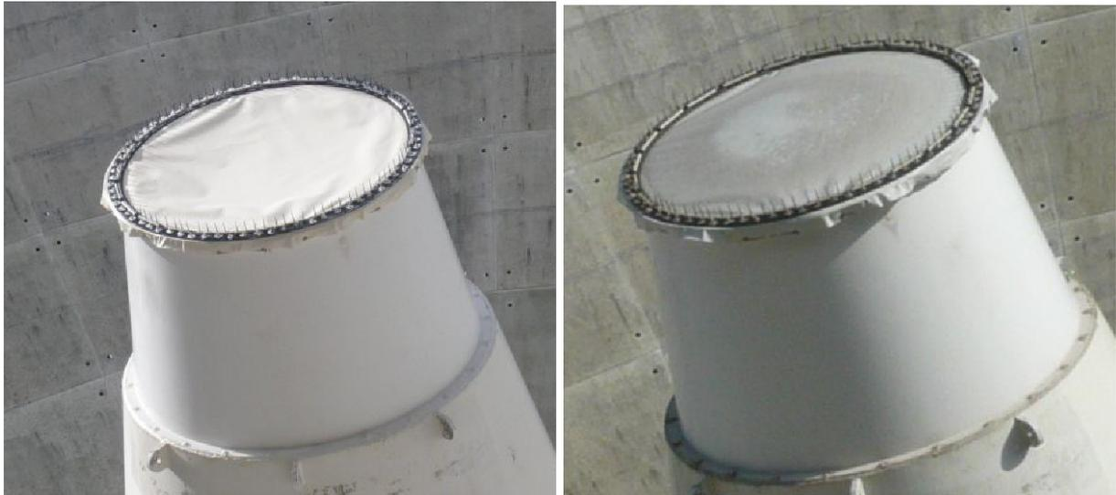
図 3.23: フィードコーン頂部をアンテナに取り付け後、デハイドレータからフィドームに送気したがフィドームが膨らまない (左写真)。GORE-TEX 膜材に塗装後、膨らむようになったフィドーム (右写真)。
