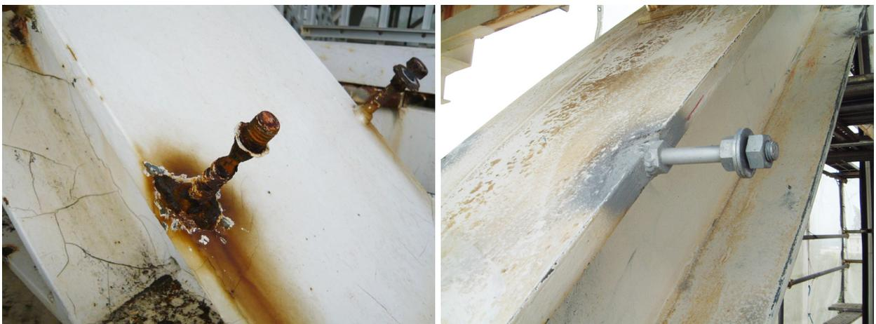
図 3.4: 腐食が進行していた日射カバーを固定するボルト (左写真)。日射カバーを固定する古いボルトを撤去、新しいボルトを取り付けた (右写真)。
