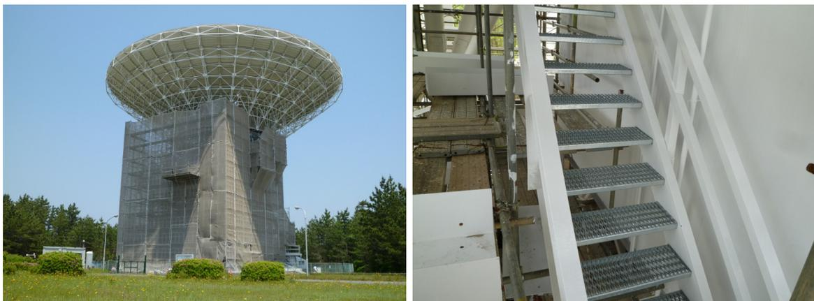
図 3.9: (左写真) 階段、通路の補修塗装等ができるように足場を仮設、その回りに飛散防止用のメッシュシートを取り付けた。右側面が途中から張り出しているのは、EL ベアリングへの階段、ステージがあるためである。(右写真) 腐食していた階段の踏み板を撤去後、階段の側桁、手すり等を塗装後、溶融亜鉛メッキした踏み板を取り付けた。
