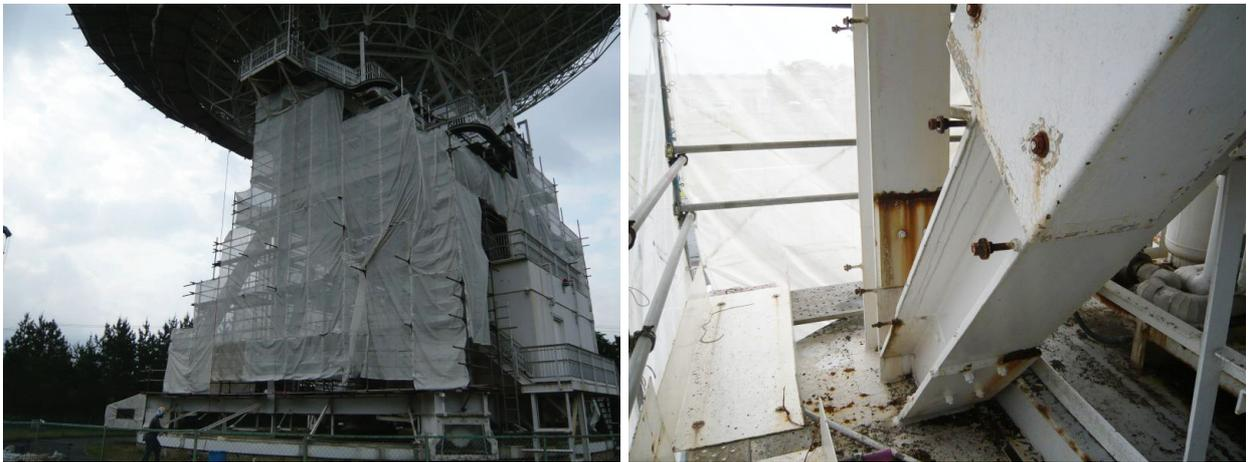
図 3.3: アンテナ架台構造部仮設足場に飛散防止用のメッシュシートを取り付け中 (左写真)。アンテナ架台の日射カバーを取り外し。支柱接合部の補強プレート周囲が特に腐食が進行している (右写真)。
