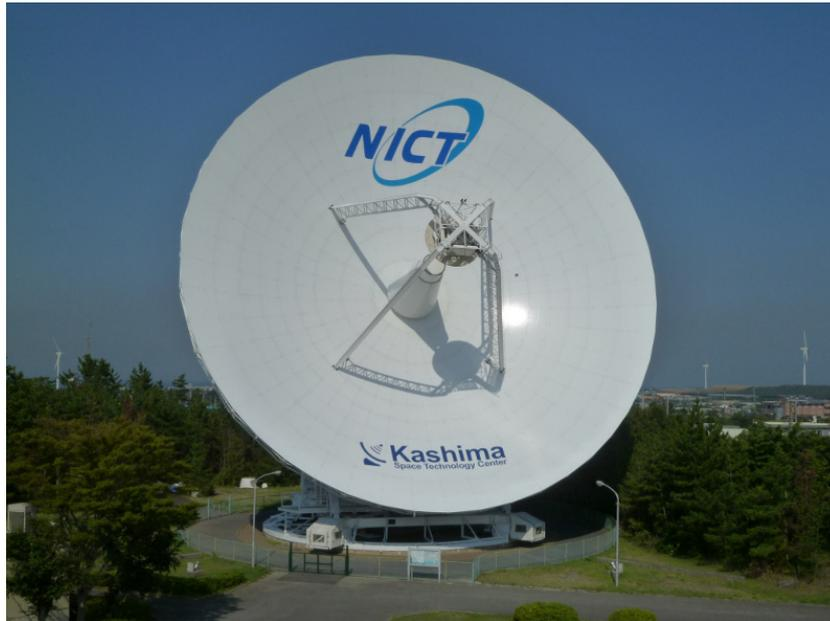
図 3.10: 補修塗装等が完了して、主鏡面にはロゴが貼り付けられた。
