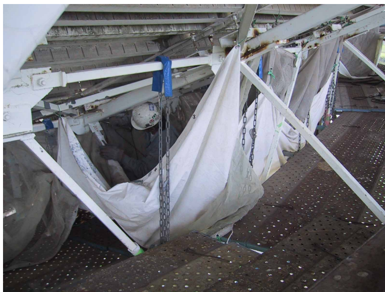
図 25: 補修塗装、溶接の前に養生シートを仮設した状態。
