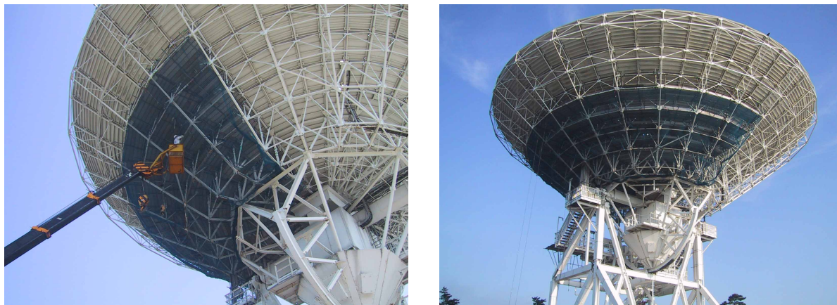
図 24: 背面構造部の補修塗装、溶接のために仮設した足場と落下防止ネット。
