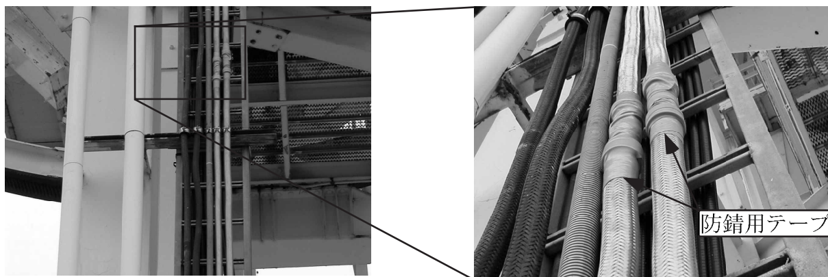
図 22: 右側の 2 本が新設した配管で、左側の 2 本は従来使用していた配管である。新設した配管の接続部分には防錆テープを巻いた。
