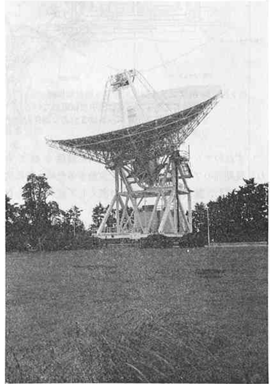
第 5 図 34 m アンテナ外観
