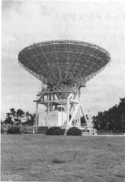
第1図 鹿島局 34 m アンテナ
