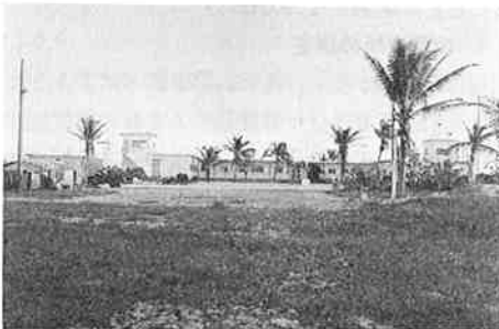
第6図 隊庁舎の全景 向かって左側が自衛隊隊舎、右側が気象庁庁舎
