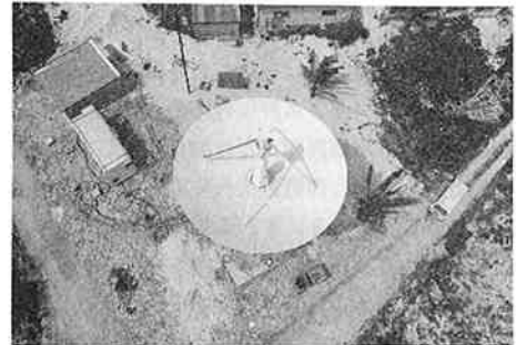
第21図 完成したアンテナ，および観測設備の上空からの図 左から発電機収納倉庫，観測用シュルタ，10メートルアンテナ，図の上方に在るのは，気象庁の施設。
