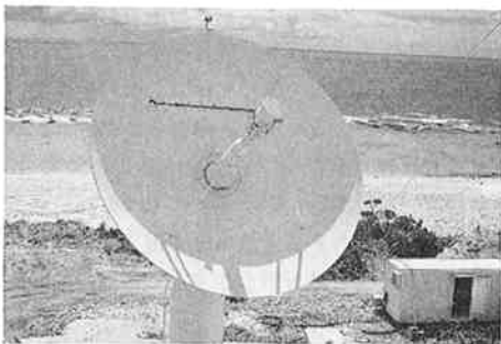
第24図 完成した西太平洋南鳥島 VLBI 局 10メートルアンテナ
