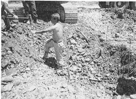
第17図 アース棒の打ち込み 打ち込みば幾らでも入る。
