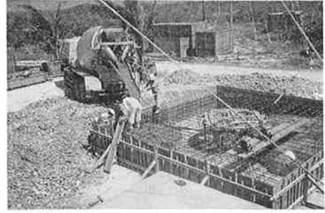
第18図 10メートルアンテナの基礎工事
