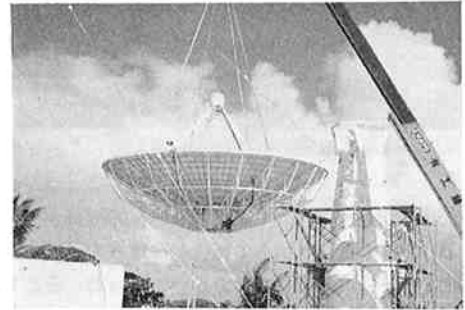
第20図 アンテナディッシュ部取り付け
