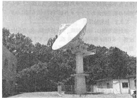
第5図 周辺樹木によるブロッキングを防止するためにマウントタワーを高上げた小金井局のKSP・VLBI観測用アンテナ
