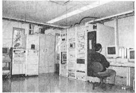
第5図 鹿嶋副中央局（観測局舎）観測室の機器設置状況
