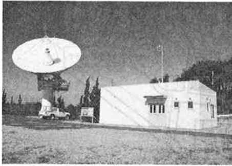
第3図 鹿嶋副中央局（観測局舎）の外観
