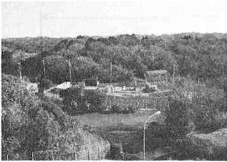
第10図 館山観測局の工事着工状況
