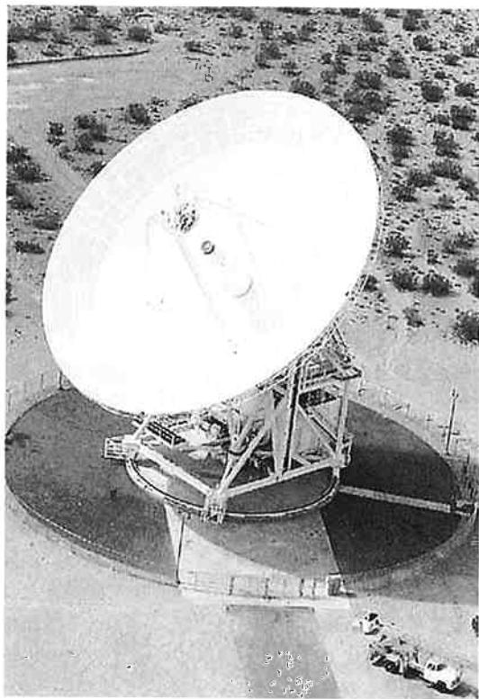
第2図 カリフォルニア州ゴールドストーンにおける NASA DSS-15 と呼ばれる同型アンテナ。周波数は 2.8GHz しかも搭載されず、周囲のパネルがメッシュ化されている。
