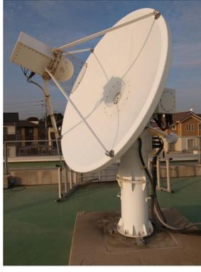
Fig2 → 超小型アンテナ。鹿島と小金井に2局ある。各パーツに分解&運搬可能である。
