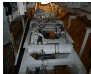
図2a. 34mアンテナの現Cバンドフィード。
