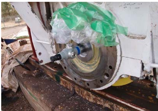
図1: 交換された新しいホイールは望遠鏡を使ってレール円の中心軸に対してアラインメントをとった。
