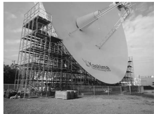
図 10: 鹿島 34m 背面構造部の補修塗装(4 月～5 月) アンテナ傾斜時に地上に近づく箇所に足場を仮設、下側の三分の一程度の補修塗装を実施した。毎日の作業終了後には強風に備えてアンテナを天頂へ戻した。
