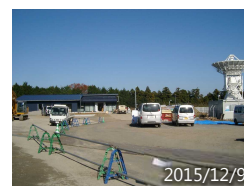
石岡局の現在の様子 局舎の外装はほぼ終了し、現在内装工事中
