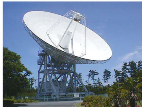
図1: 32GHz帯の新受信機を搭載した34mアンテナ。
